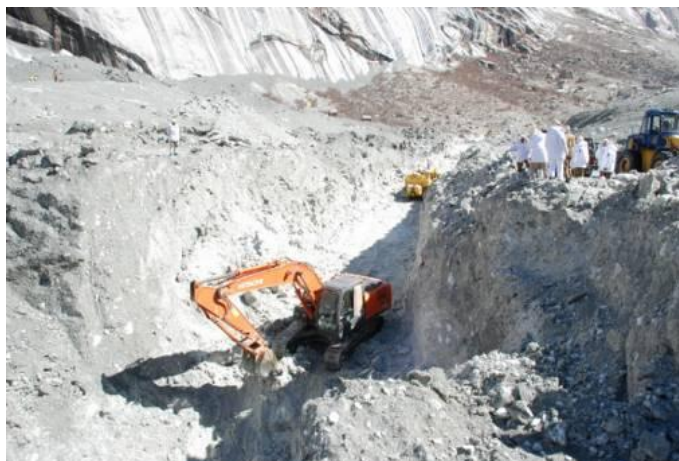
Рис. 14 – Тяжёлая техника выкапывает тела погибших и отводной канал. Фото предоставлено ISPR. Обратите внимание на утрамбованные обломки, состоящие из льда и раскрошенных камней. Взрывные работы оказались безуспешными.
